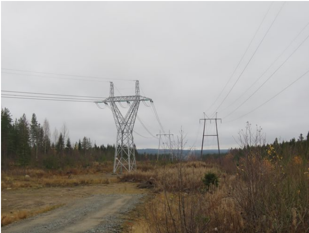
Kuva 21. Voimalinja hankealueen koillisreunalta koilliseen.
